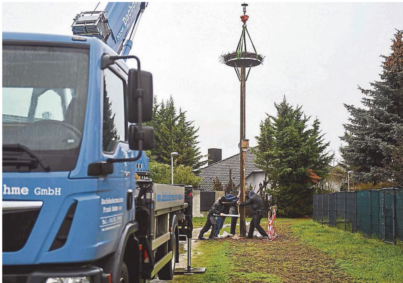
Mit dem Kran eines Groß-Gerauer Dachdeckerunternehmens wird das Storchennest in Geinsheim umgesetzt.
